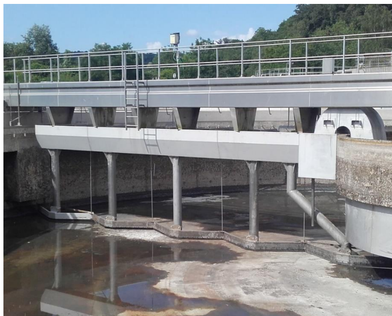
Travaux Clarificateur : réhabilitation goulotte et pont
