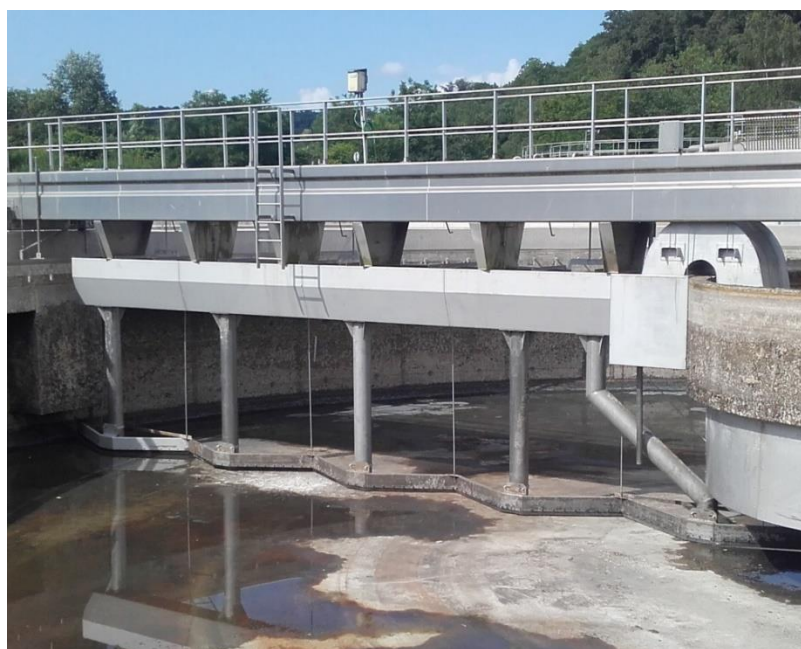
Travaux Clarificateur : réhabilitation goulotte et pont
