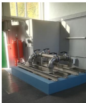
Photo : Réhabilitation du puits d'Haropré
