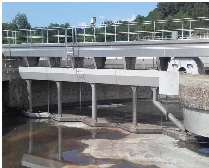
Travaux Clarificateur : réhabilitation goulotte et pont
